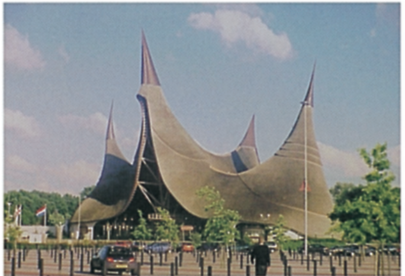
Figuur 17.2 Rieten dakbedekking Entree Efteling te Kaatsheuvel
